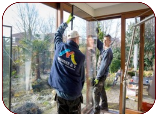
HR++ glas in bestaand kozijn Kierdichting ramen en deuren
