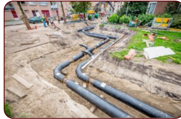
Aanleg warmtenet buiten
