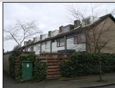
Dakkapellen met een zelfde dakvoet geven een gelijkmatig ruimtelijk beeld.
