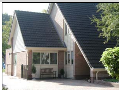
Aanbouw met materiaal- en kleurgebruik overeenkomstig het hoofdgebouw en dakhelling gelijk aan het hoofdgebouw.
