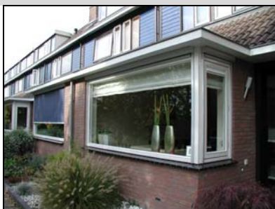
Uitbouw die in hoogte en breedte goed aansluit op de goothoogte van het gebouw.
