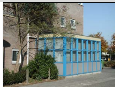
Aanbouw die in kleur- en materiaalgebruik niet aansluit bij het hoofdgebouw.
