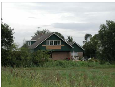
Bebouwing is voorzien van een kap.
