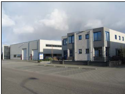
Karakteristieke bebouwing op het Schepenveld.
